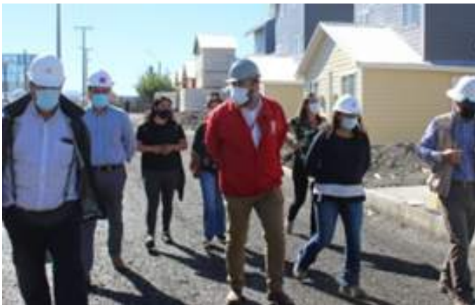
Recorrido inspección obras Villa España y Comité Huépil.
