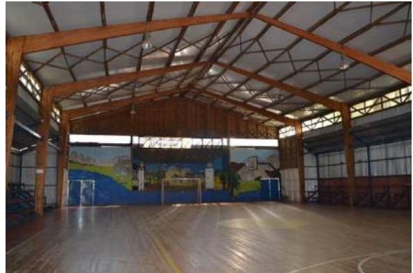
Fotografía 12: Multicancha techada de Tucapele
