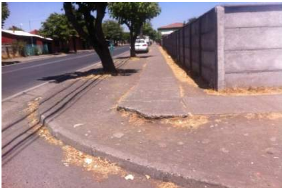
Fotografía 17: Situación de aceras en Huépil
