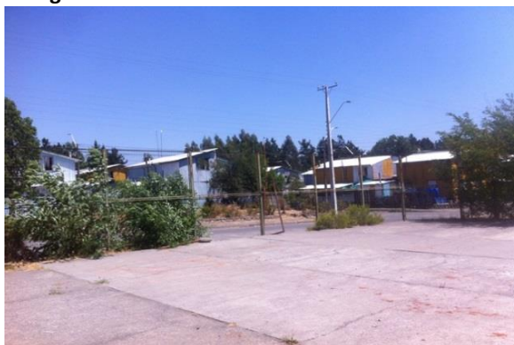
Fotografía 10: Multicancha en calle Irarrázaval
